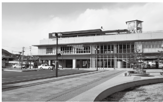
大船渡市防災センター
