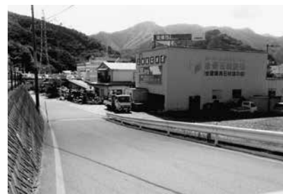
瓦礫の撤去が進み元の町並に
