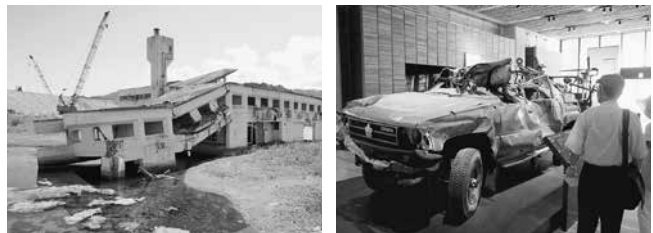
津波の力を想像させる。陸前高田ユースホステルの震災遺構と津波で流された消防団の車
