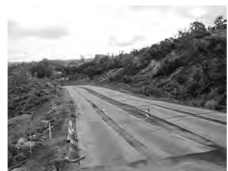
土砂崩れ地点の仮設道路
