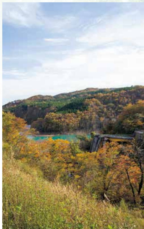
祭時大橋（落橋）展望の丘
